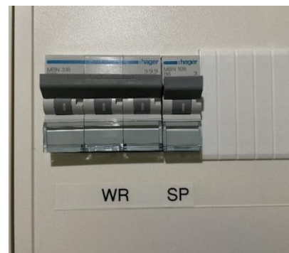
Abbildung 3 – Beispiel Sicherungen im Schaltschrank/Zählerschrank
