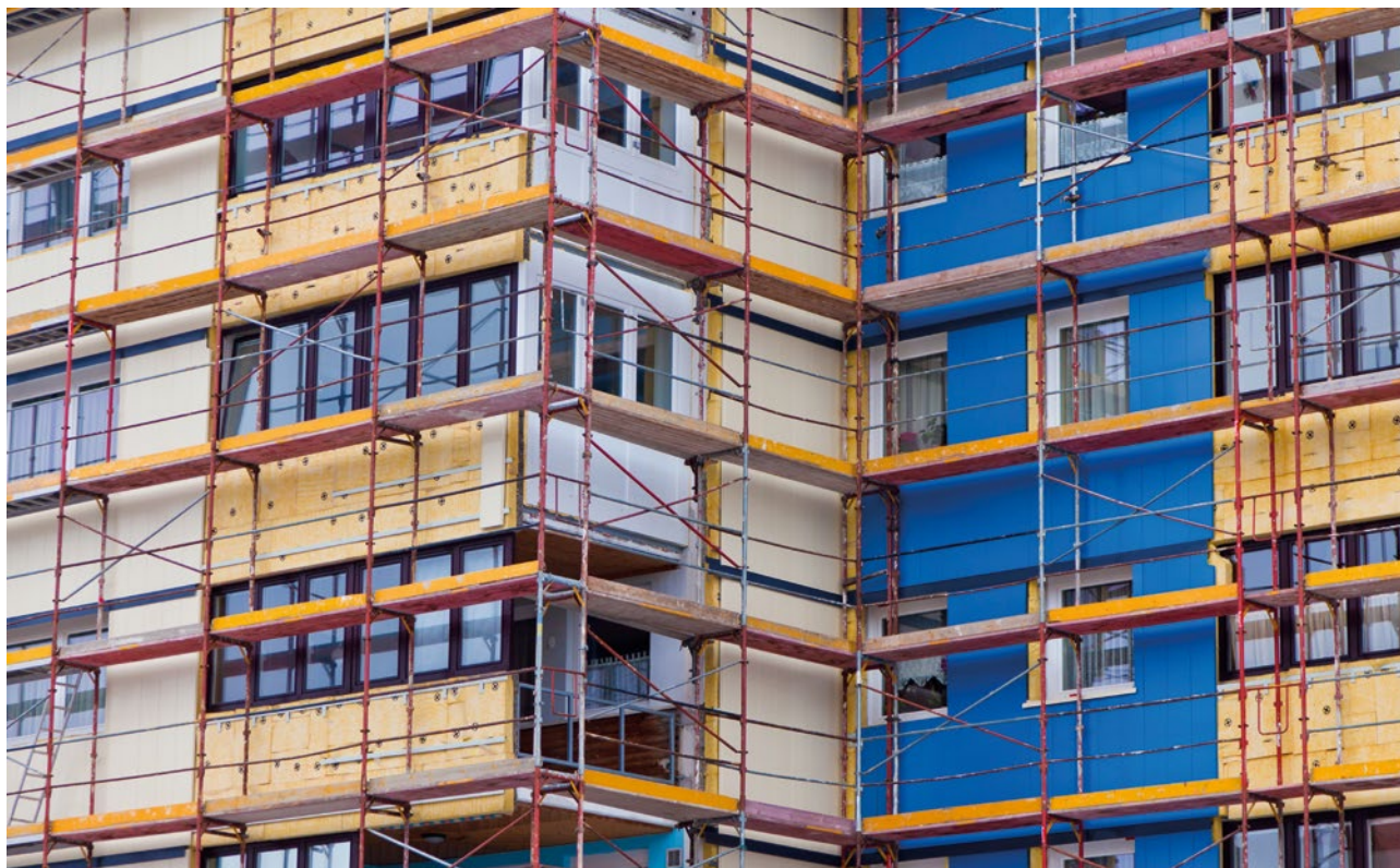
Sanierung eines Mehrfamilienhauses
