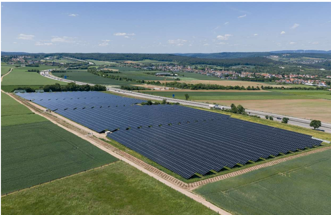
PV-Park Hettenleidelheim aus der Vogelperspektive: 15.000 Solarmodule, über 10 Millionen Kilowattstunden Strom aus Sonnenenergie, rund 3.000 Haushalte die davon profitieren können. Bildnachweis: Pfalzwerke Aktiengesellschaft
