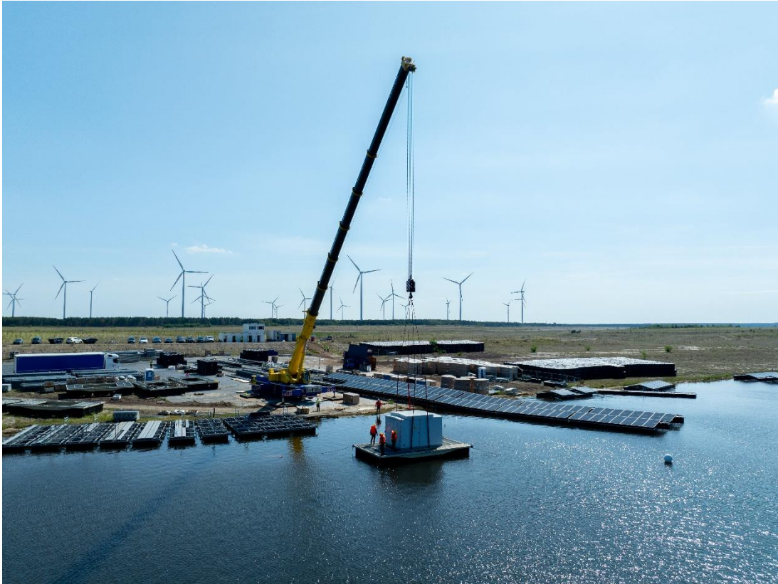
Ein Kran setzt die Trafostation in ein Trafoboot.
