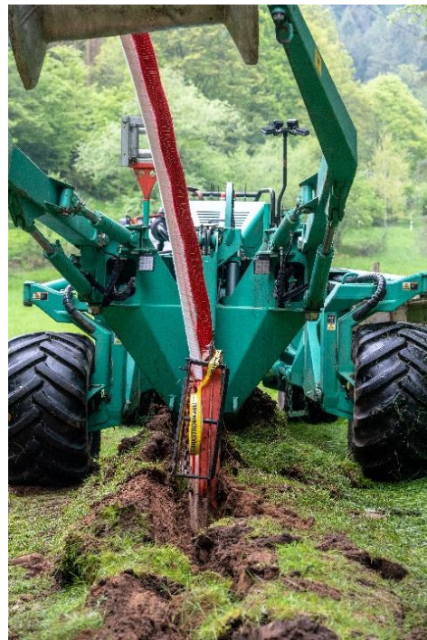
Für die Erdarbeiten kam ein Kabelpflug zum Einsatz
