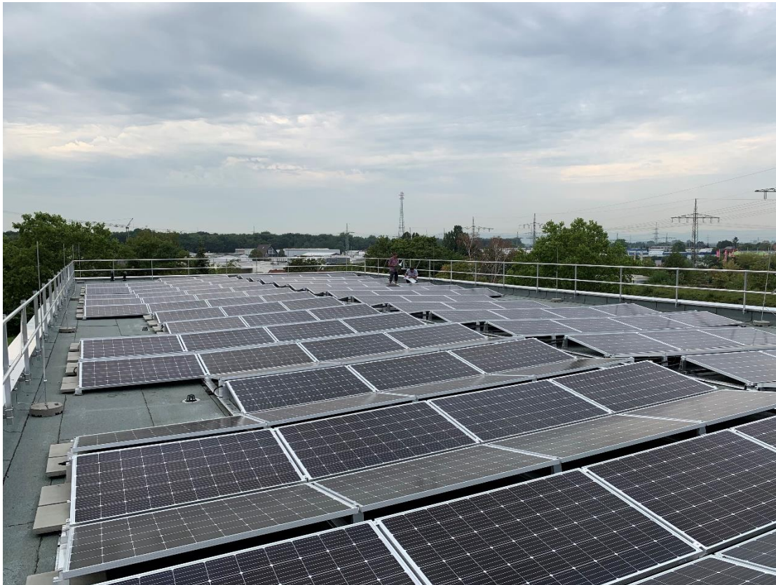
Blick von oben auf die Anlage
