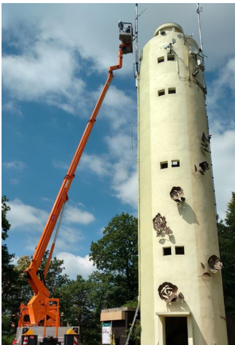
Bildunterschrift: Monteure der Pfalzwerke Netz und der Pfalzkom installieren ein LoRaWAN-Gateway auf einem Aussichtsturm in der Südpfalz.
