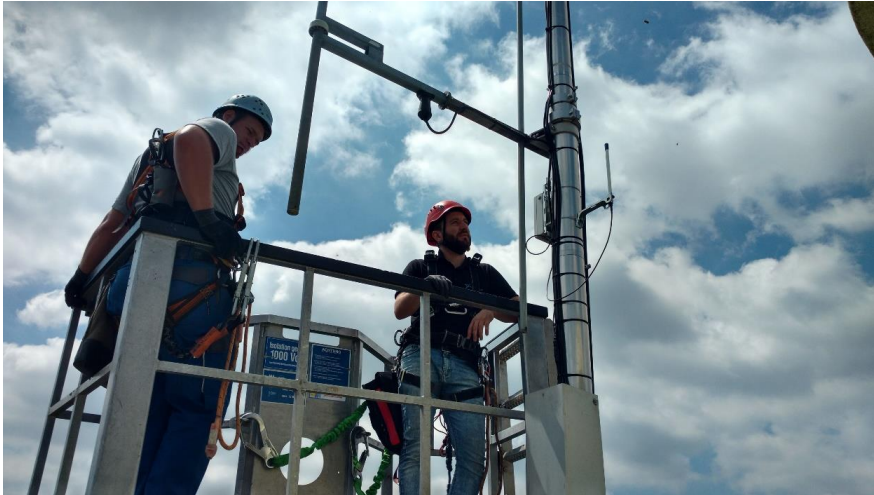
Bildunterschrift: Monteure der Pfalzwerke Netz und der Pfalzkom installieren ein LoRaWAN-Gateway, das die Sensordaten empfängt und automatisch weiterleitet.
