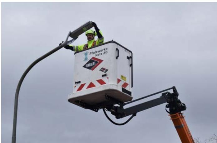
Bildunterschrift 2: Rainer Walburg (Pfalzwerke Netz AG) montiert die neuen LED-Leuchten
