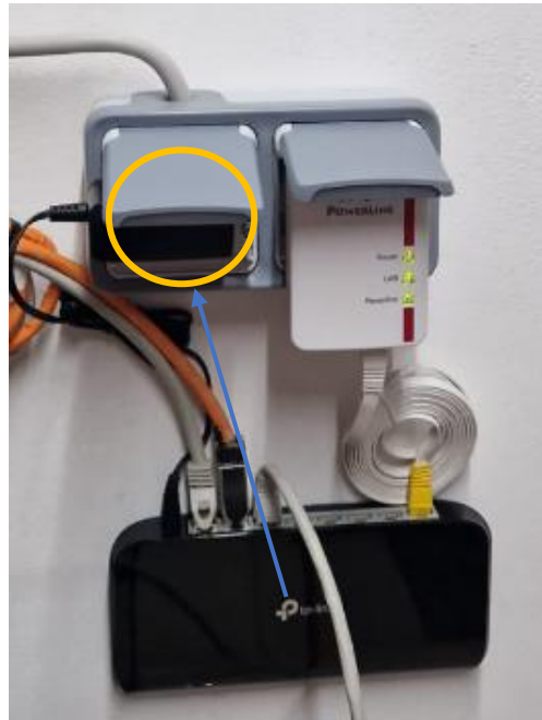
Abbildung 7 – Beispiel typischer Aufbau Switches mit Powerline
