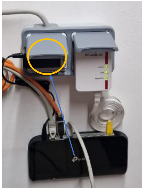
Abbildung 7 – Beispiel typischer Aufbau Switches mit Powerline
