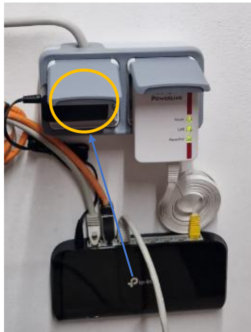
Abbildung 7 – Beispiel typischer Aufbau Switches mit Powerline
