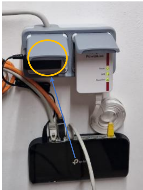
Abbildung 7 – Beispiel typischer Aufbau Switches mit Powerline
