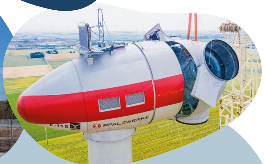
Impressionen vom Bau Windpark Rüssinger Berg
