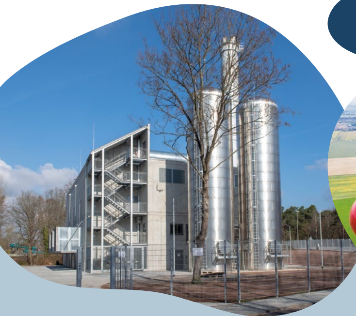
BHKW in Ramstein-Miesenbach
